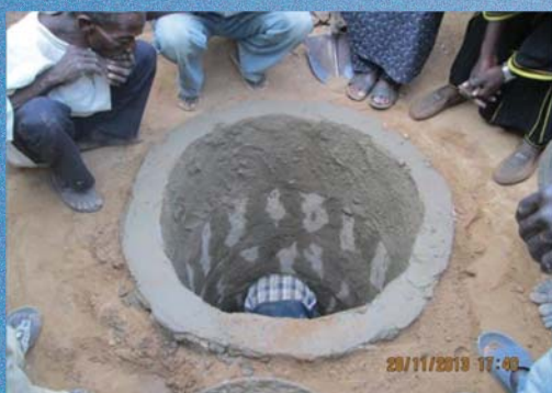
L'utilisation de l'huile de vidange pour diminuer l'infiltration d'eau à partir du toit de la latrine
