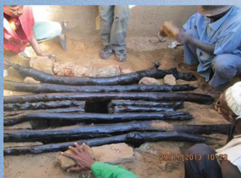
Les bois trempés dans l'huile de vidange pour résister à l'attaque des termites et l'infiltration d'eau à partir du toit de la latrine
