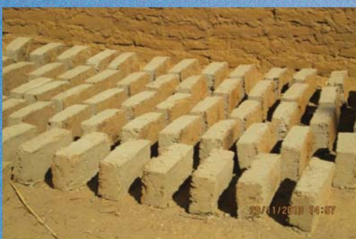
Briques en banco confectionnées pour la clôture de la latrine
