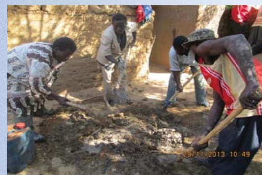
Mélange de la terre avec la bouse de vache et l'huile de vidange
