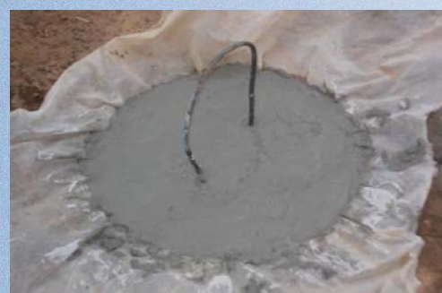
La confection de la couverture du trou de défécation
