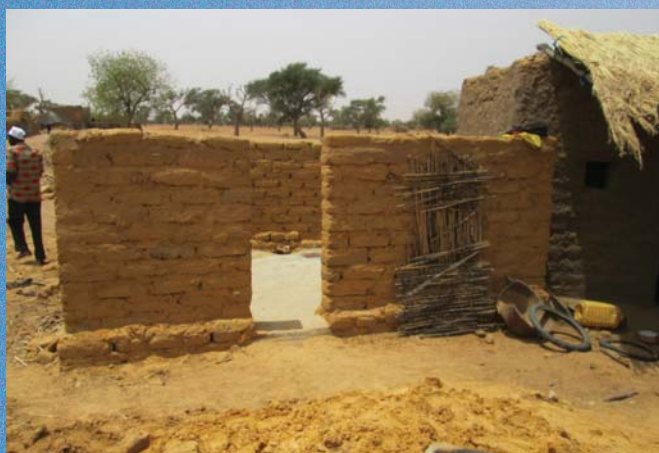
Briques en banco confectionnées pour la clôture de la latrine
