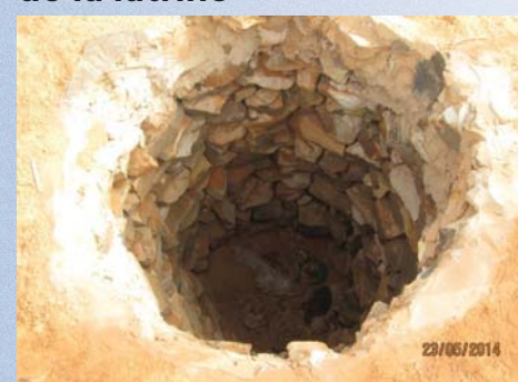
Pierres taillées pour stabiliser les parois du trou de la latrine
