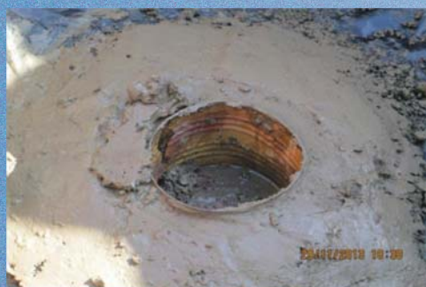
L'utilisation de l'huile de vidange pour diminuer l'infiltration d'eau à partir du toit de la latrine
