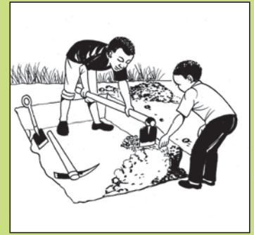
cukura icoba cya mita 0.6 ubugari, 0.9 umuramambararo hamwe na mita 5 uburebure.
